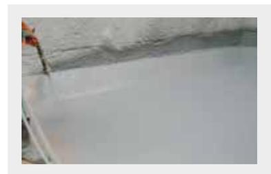
3.2. Para o encontro entre o piso e a parede, não é necessária a confecção de meia cana, deve-se deixar os cantos com 90°, porém RECOMENDAMOS o uso de tela de POLIÉSTER ou MANTA BIDIM POLIÉSTER na aplicação da segunda demão até uma altura média de 30 cm, ou seja, 30 cm na parede e 30 cm no piso. Devem-se aplicar as mesmas quantidades de demãos recomendada para o sistema.
